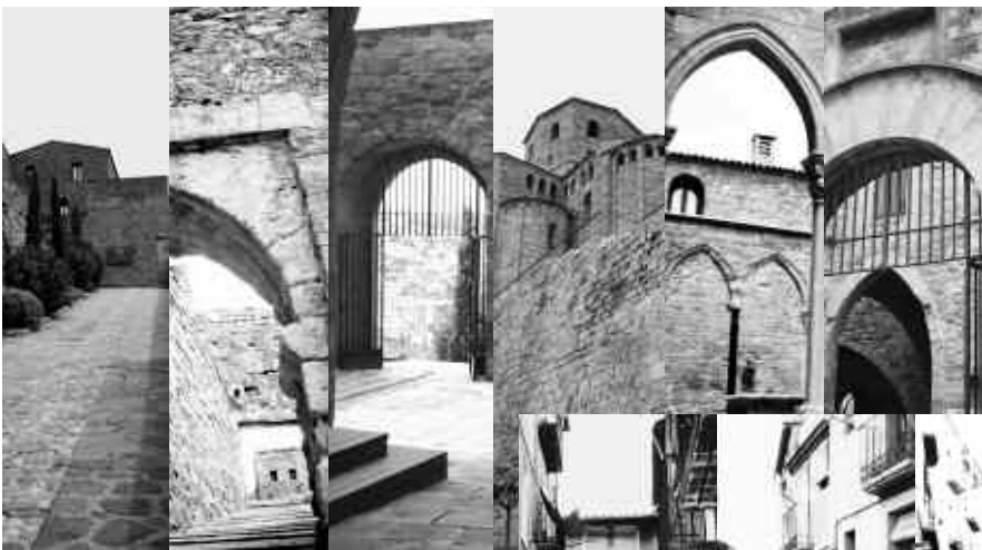
Conjunt monumental del castell de Cardona i algunes de les diverses estructures que l'integren
