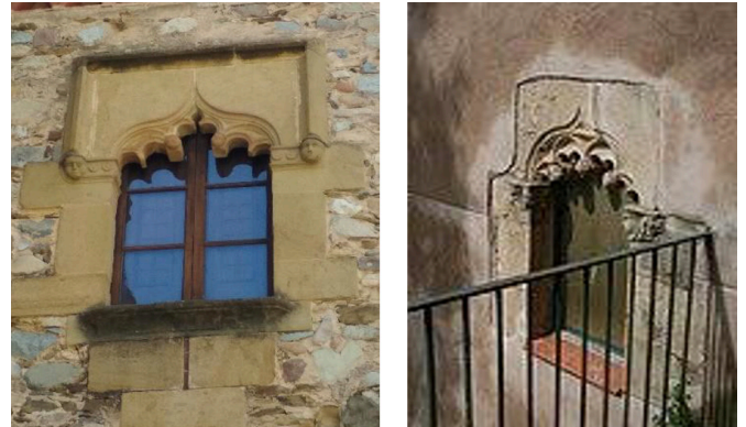
Figura 1. Comparativa entre la finestra de la casa pairal i una finestra amb llinda en forma d'arc conopial fisonat, al Castell de Mogoda, Santa Perpètua de Mogoda (Viquipèdia, 2023)
