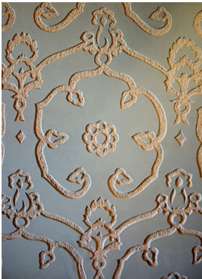
Detall de l'esgrafiats del vestíbul d'entrada de la Casa Garí (1899-1900), a Argentona. © Daniel Pifarré.
