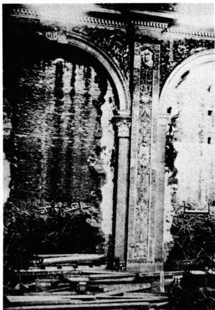
Figura 2. Iglesia de la Ciudadela de Barcelona . Interior. Pilastra entre el segundo y tercer tramos de la nave (lado derecho). Finales del s. XIX (de una copia en AHCB, Secc. de Documentación Fotográfica).
