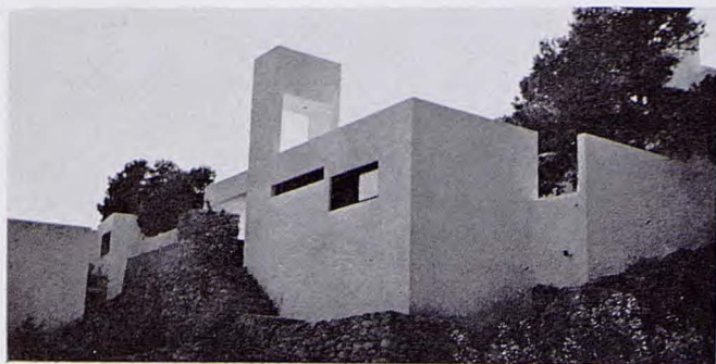
Casas - Le Carrioux, y Lloll, Cala Sant Vicent. Parroquia de Sant Vicent de sa Cala. Municipio de Sant Joan de Labritja. Constantine Wallace, Arquitecto. 1971-1972.
