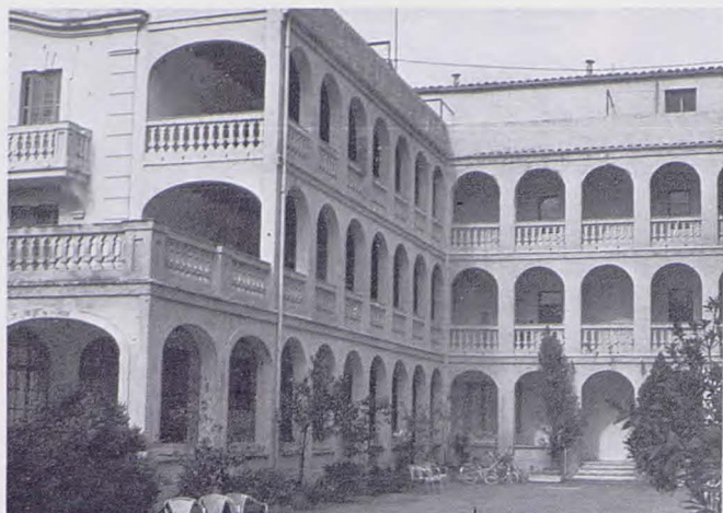
Fachada sur. Aspecto parcial.
