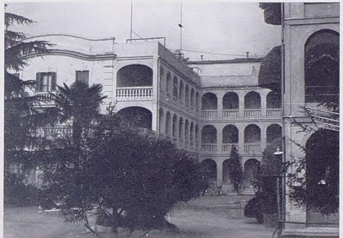
Fachada sur. Galerías del patio.
