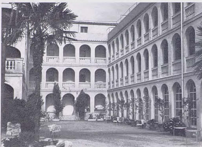
Fachada sur. Otro aspecto.
