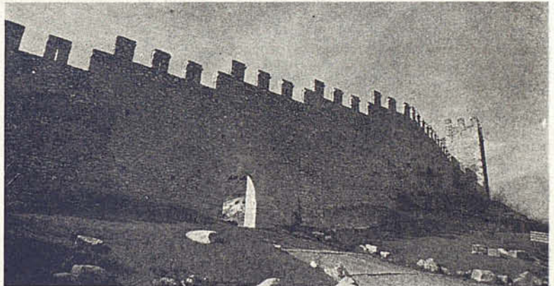
El baluarte de Santa Anna antes de la reconstrucción, en el proyecto de J. Martorell y tal como ha sido reconstruido. El escalonamiento del muro y la puerta de acceso no existieron nunca.
