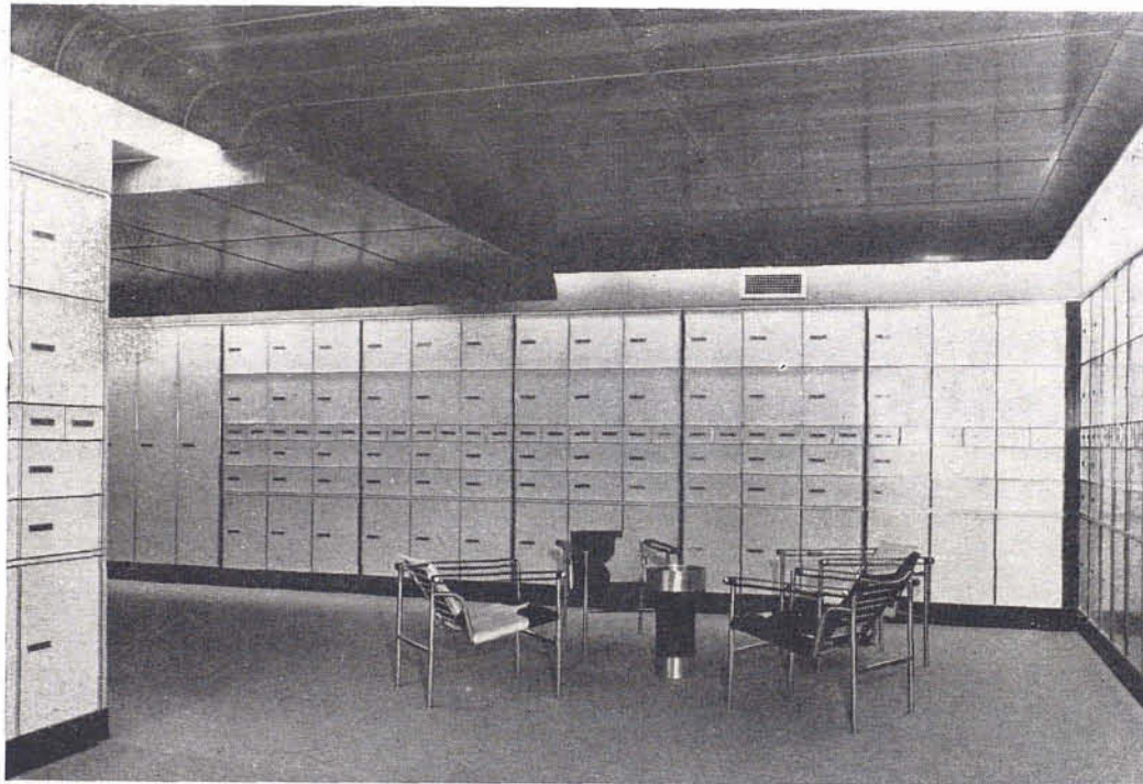
El nivel de exigencia de los locales ubicados en los sótanos, es consecuente con el mantenido en el resto.
