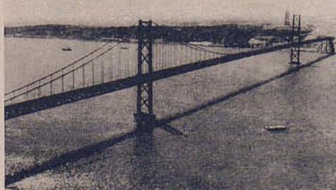
82,50 m respecto al nivel de las máximas avenidas, en la pila meridional. Las susodichas cepas se ejecutaron con cajones metálicos flotantes, que se lastran con hormigón para sumergirlos por elementos de 10 m de altura. En su interior había 28 cilindros huecos que sirvieron como pozos de dragado para perforar las capas de terreno y como elementos auxiliares de flotación, a cuyo efecto se cerraron por arriba con coberteras hemisféricas para insuflar aire comprimido a  $14 \text{ kg/cm}^2$ .
