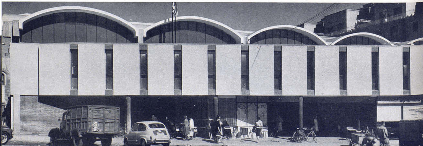
Fachada Sur. Las oficinas se alojan en el volumen que avanza respecto a las naves de cubierta.
