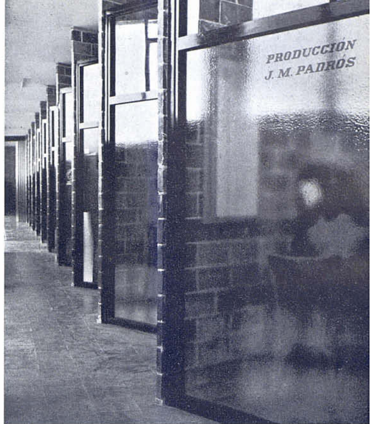
Oficinas desde el pasillo
