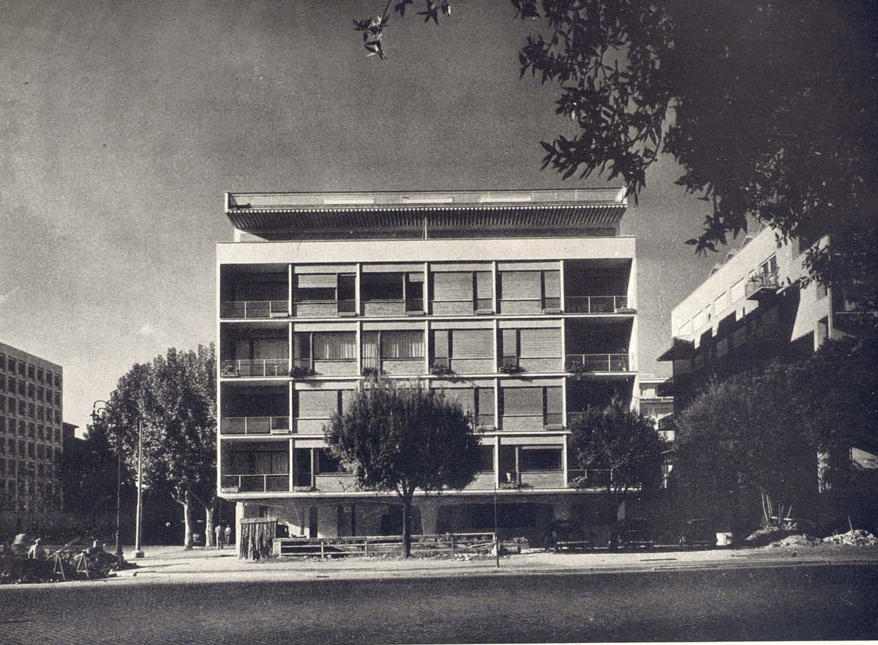
Casa de la calle del Circo Máximo esquina al paseo Africa, terminada en 1951. Estructura en cemento armado. Sobreestructura a base de ladrillo hueco. Revestimientos enlucidos. Antepechos de ventanas en cortina. Barandillas de balcones en cristal Securit.
