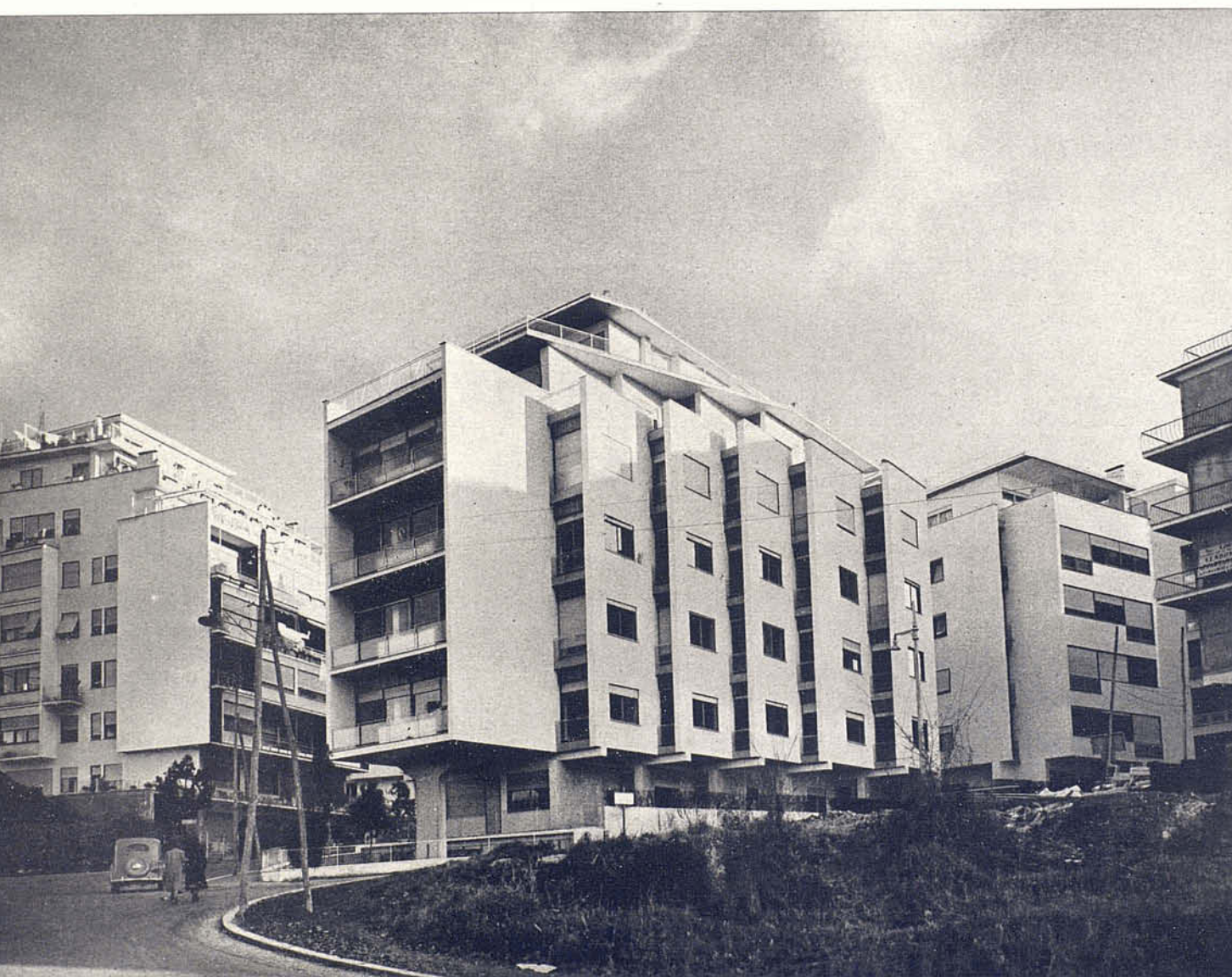
Vista de una casa formando ángulo entre las calles de San Valentino y de Pollaiolo. Puede observarse la disposición adoptada para procurar a cada una de las viviendas la vista al exterior.
