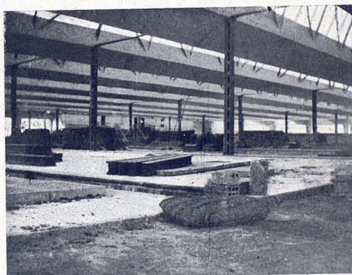
Nave de telares
