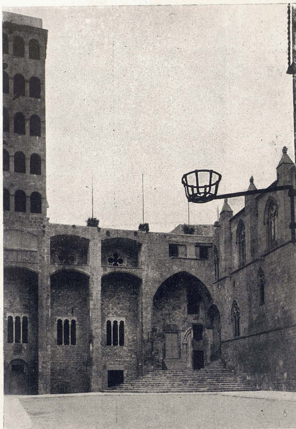
Fig. 1. — La plaza del Rey, con la torre llamada del rey Martín, la fachada del «Tinell» y la capilla de Santa Águeda
