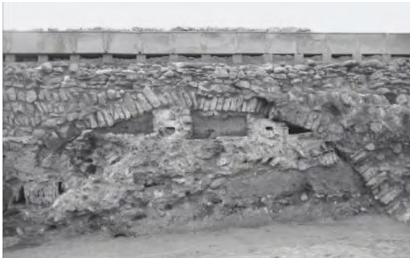
Figura 11. Pont de les Caixes (imatge parcial). Sota el parament medieval i modern es pot apreciar el sòl de la conducció romana, els sediments que la rebleixen i l'obra medieval associada a l'arc de descàrrega, (Remolà et al 2011, 199).
