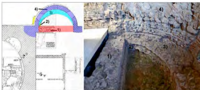
Figura 34. Diverses fases constructives de l'absis. 1) mur façana nord. 2) mur perpendicular. 3) primer absis amb forma de segment de cercle. 4) segon absis amb forma semicircular. (Imatge extreta de Puche; López 2017, 178).
