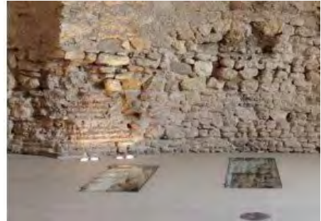
Figura 27. Actualment es poden veure la cripta i les escales (restes) que hi menen per les obertures al paviment de la sala 7 (museïtzada) (Imatge, fotografia de Ricard Ballo, 2015).
