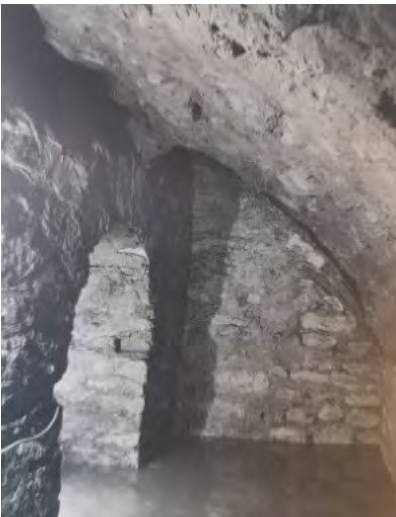
Figura 26. Interior de la subcripta. S'hi veu un dels dos arcs del mur mitger longitudinal així com el sòl cobert d'aigua. (Imatge extreta de Hauschild; Arbeiter 1993, 40).
