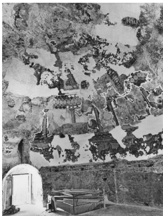
Figura 51. Segon pis de l'habitatge. S'hi pot veure les escales per accedir-hi, la finestra sud de la sala 7 i el mosaic ja netejat pel DAI. El terra d'aquesta sala va servir de plataforma per restaurar el mosaic. ( https://www.mnat.cat/fotografies/92623centcelles3.jpg ).
