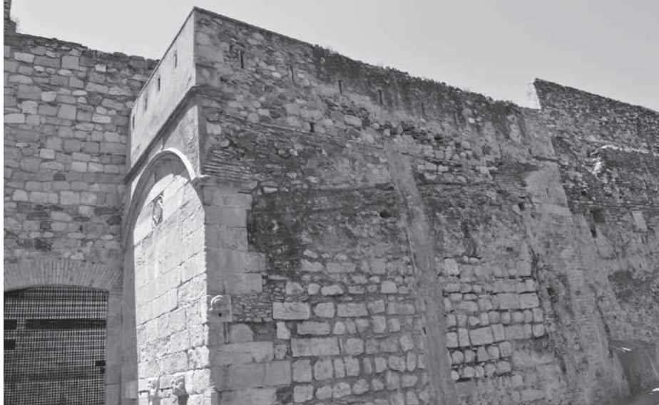
Paret del castell de la Selva davant l'antic pati de la Carnisseria, actualment coneguda com a Plaça de Sant Andreu. Cal observar la part superior recrescuda al segle XIX i les espitlleres de rajola (Foto Maties Solé).
