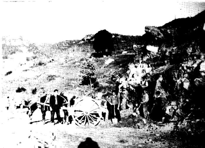
Treballadors de la carretera l'any 1959.
