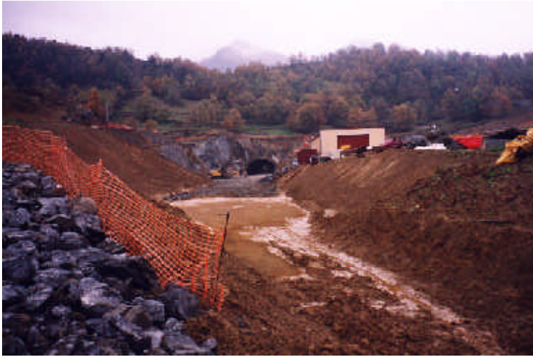
La carretera de Vic a Olot pel túnel de Bracons.
