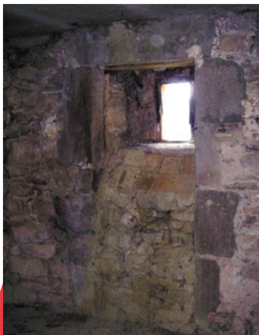
Interior del campanar a l'indret de la petita finestra. Foto: Jordi Gumí
