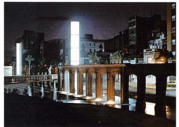
CLOT-PARK. EHEMALIGE WERKSTÄTTEN DER SPANISCHEN STAATSBAHNEN, RESTAURIERT. (ARCHIT. D. FREIXES - V. MIRANDA). FAD-PREIS (1986), PRINCE OF WALES-PREIS FÜR STADTGESTALTUNG (1990)
