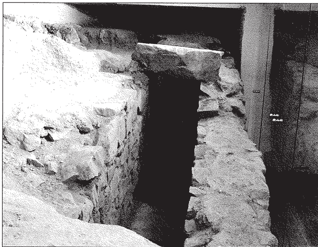
Fig 5. Claveguera romana visible des del pàrquing de l'edifici d'habitatges. Museu de Badalona. Fotografia: A. Cartagena.
