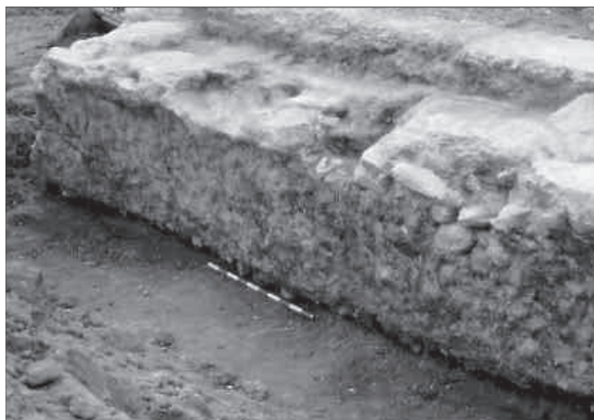
Mur lateral de la fonamentació de l'estructura romana, amb més d'1,50 m de fondària.
