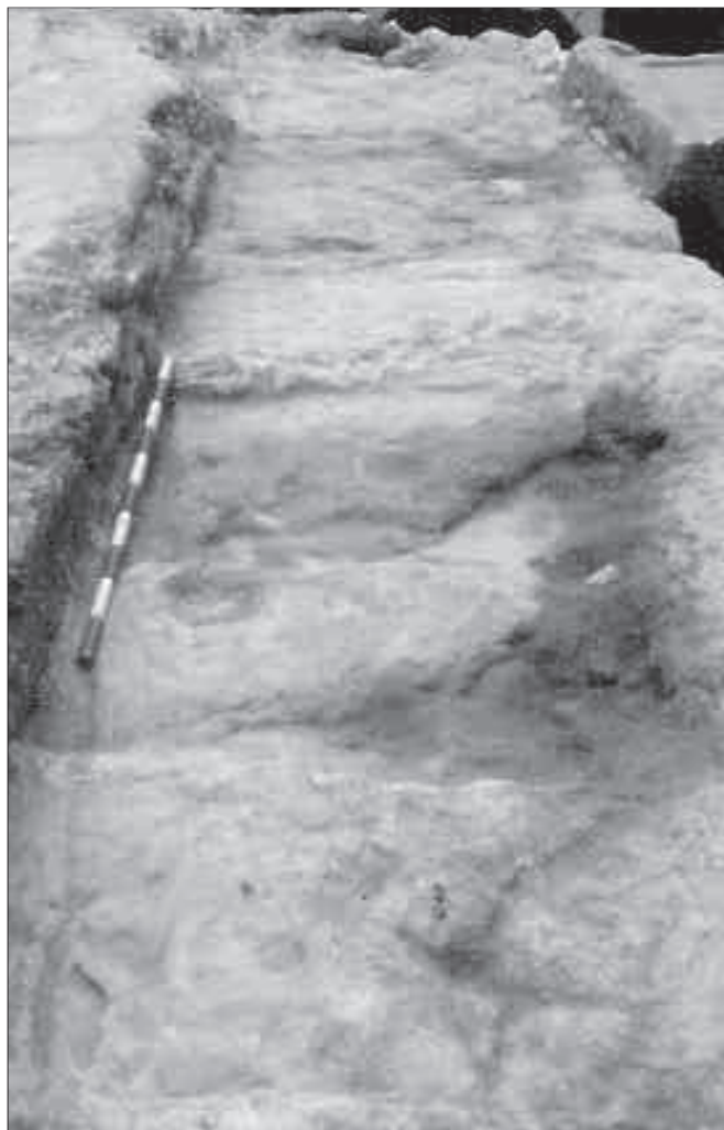
Empremtes dels blocs de pedra que formarien els murs laterals de l'estructura romana.
