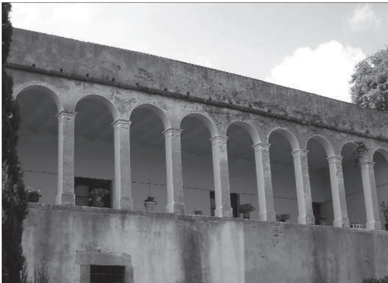
Galeria de l'Obra Nova de Sant Jeroni de la Murtra. Fotografia de l'autor.
