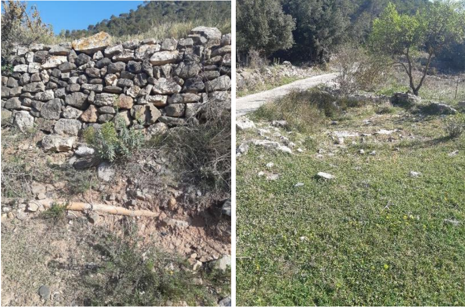
Restes de la canalització i la bassa del Cerdà
