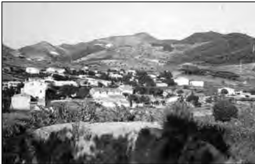
Vista de Can Torrens, carrer Sant Pere i sector Mas Carbassa/Can Toni, agost de 1965. (Fotografia Miles Broughton)
