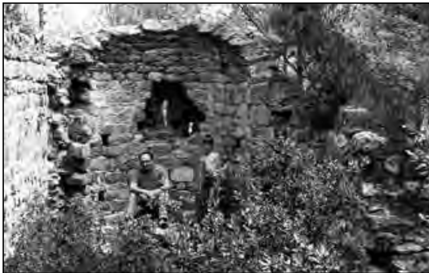
Interior de l'ermita romànica de Sant Martinet, 1966. (Fotografia Miles Broughton)
