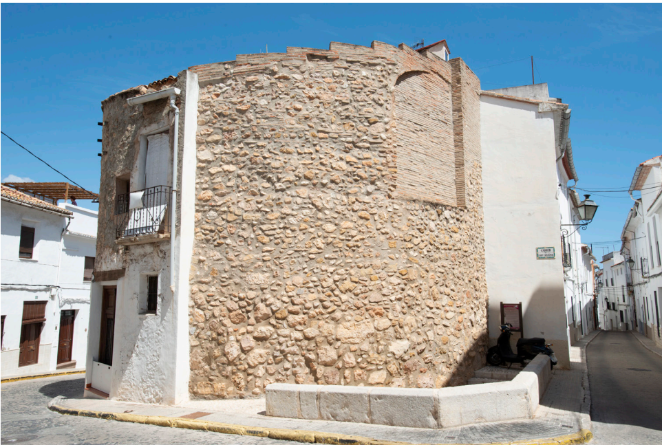
Torre de la muralla, s. XVI (Foto de Salvador Mañó, 2023).
