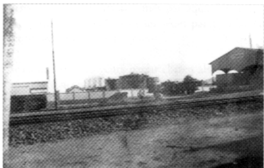
Instal·lacions de CAMPSA des de l'estació, l'any 1939. [FFV]
