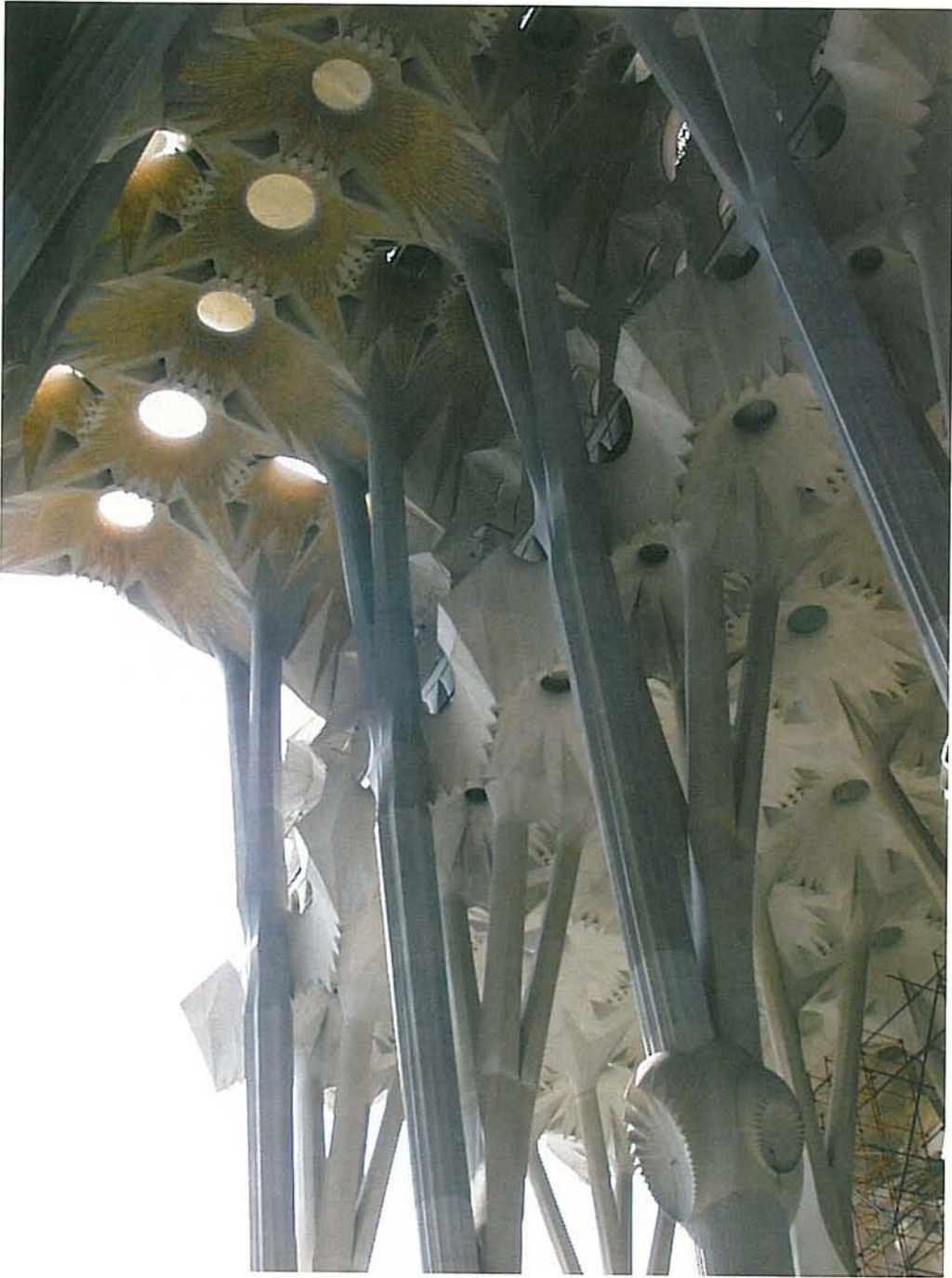
Fig. 6. Conjunt ja realitzat de l'estructura arboriforme de les naus del Temple.
