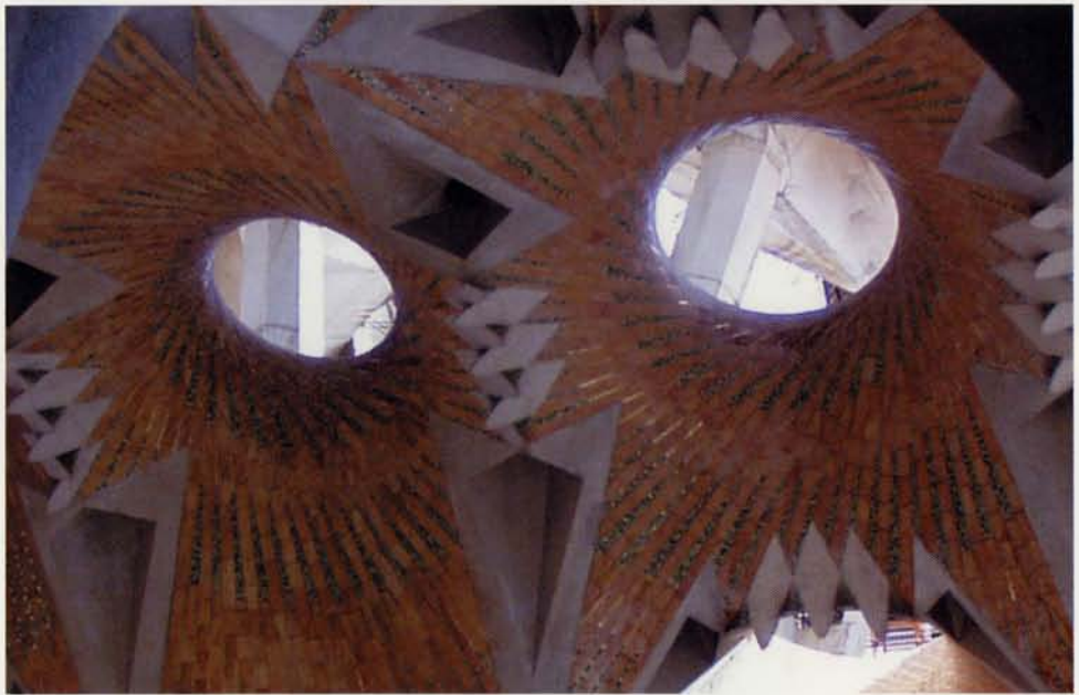
Fig. 12. Voltes de maó de pla seguint les generatrius dels hiperboloids de la nau central del Temple de la Sagrada Família.
