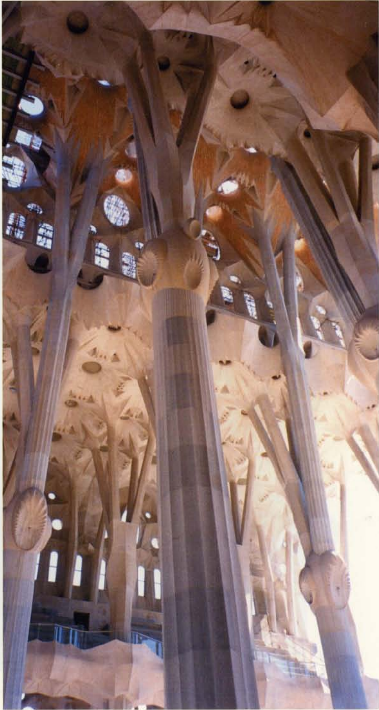
Fig. 7. Fotografia del conjunt de les naus.
