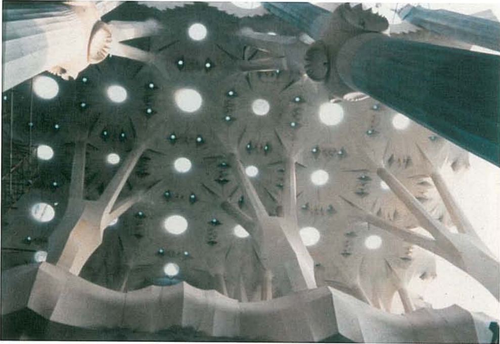
Fig. 10. Intersecció estelada d'hiperboloides a les voltes catalanes de la nau central i laterals del Temple.
