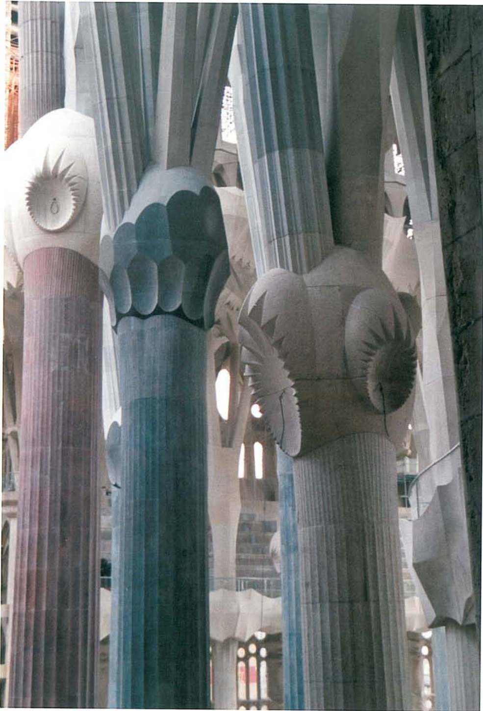
Fig. 8. Columnes i nusos. Detall pòrfir, basalt i granit.
