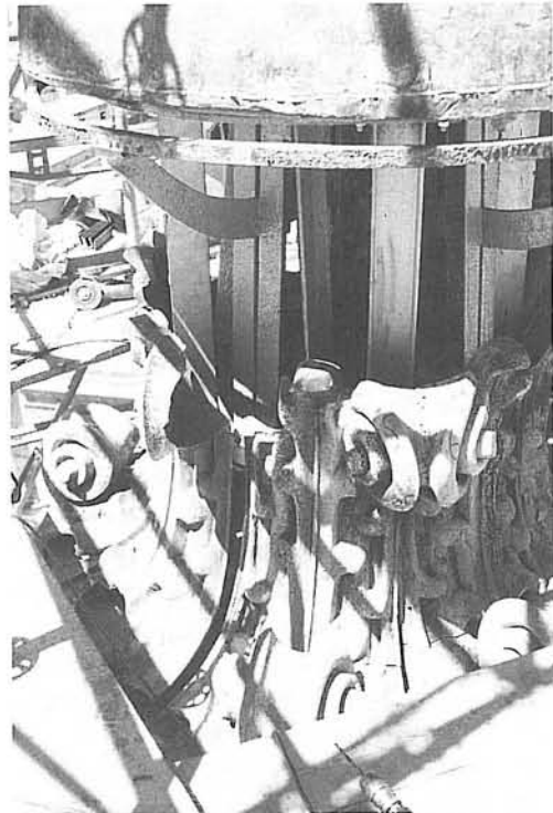
Fig. 8.- L'estructura definitiva d'acer inoxidable i els elements de ferro existents protegits amb pintura especial amb la base de bronze d'encofrat preparats per formigonar.
