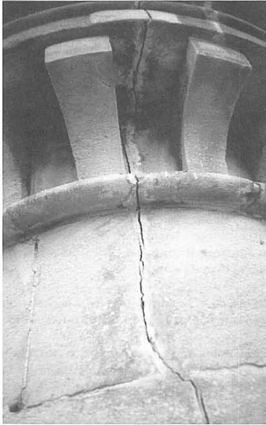
Fig. 3.- Esquerdes sospitoses en la peanya de suport de pedra de Montjuïc.
