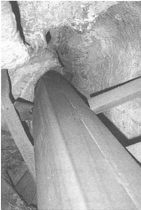
Fig. 7.- Bon estat dels elements de ferro laminat de subjecció del bronze a l'interior de la imatge.
