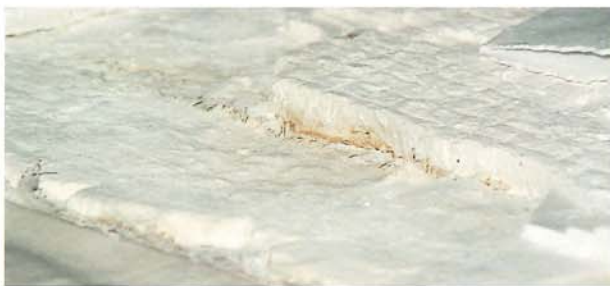
Detall de l'eliminació mecànica del gruix de guix de l'antic suport, i amb això queda al descobert el morter original.
