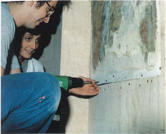
Anclatge del nou suport mitjançant cargols d'acer inoxidable.
