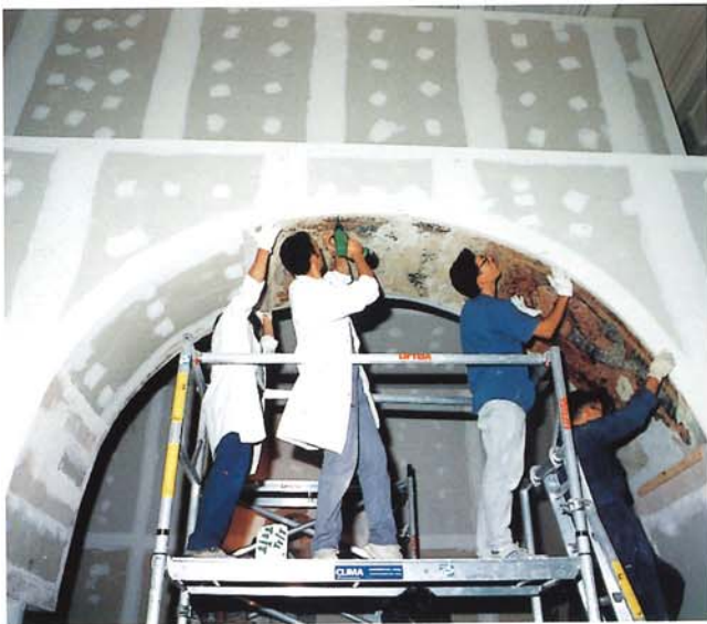
Muntatge de la pintura a la sala. El policarbonat alveolar és fixat amb cargols al Pladur, que facilita tant el muntatge com el desmuntatge. L'adaptació a la curvatura de l'arc és molt senzilla.
