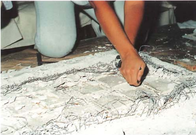
Detall de l'eliminació de l'estructura interna de filferro.
