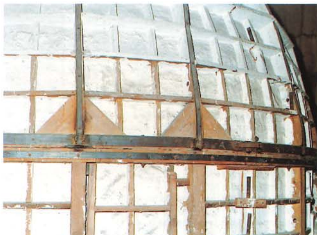
10. Revers de l'absis de Sant Climent de Taüll. Detall de l'encaix entre la semicúpula i el semicilindre subjectats amb passamans de ferro.
