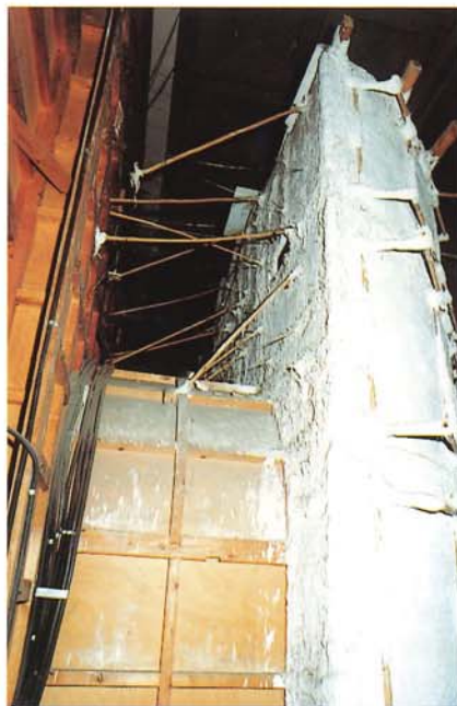
9b. Revers de l'absidiola lateral esquerra de Sant Joan de Sorpe. Es constata que en aquest cas el cablejat elèctric passava per damunt del suport. A més, s'observa el muntatge de l'estructura d'aquest absis, dut a terme amb canyes, fil d'espàrt i guix.
