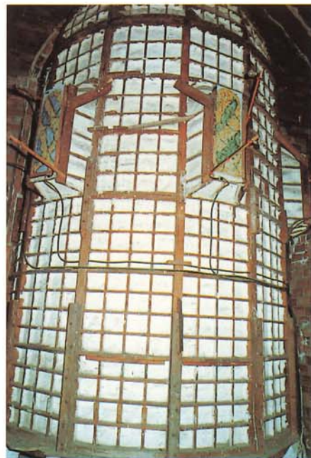
11. Revers de l'absis de Santa Maria d'Àneu. Els muntants principals estan reforçats amb travessers de fusta i en algunes ocasions són de ferro. També se'n van col·locar d'horizontals, de perpendiculars i de totes mides, amb la finalitat de fermar l'estructura.
