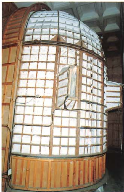
9a. Revers de l'absis d'Esterri de Cardós. El cablejat elèctric passava per damunt dels suports de les pintures sense cap protecció, així com les caixes de distribució elèctrica i bombetes directament collades damunt de les quadrícules.
