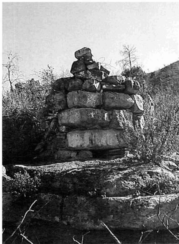
Vista frontal (façana nord).
