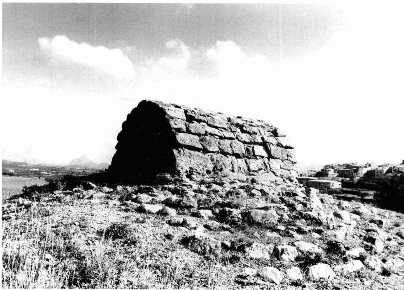
Vista exterior de la cúpula del povet on el forat d'accés ha estat cobert amb obra amb volta de canó, amb obertures tapades provisionalment.
