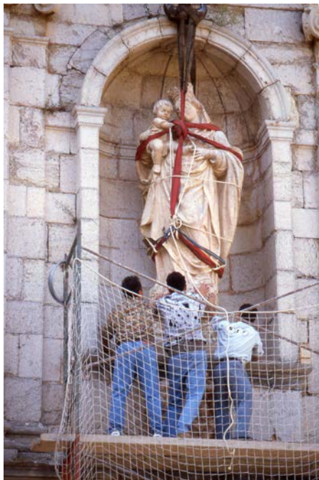
5. SIT i paletes asseguren la imatge i primers intents infructuosos.
