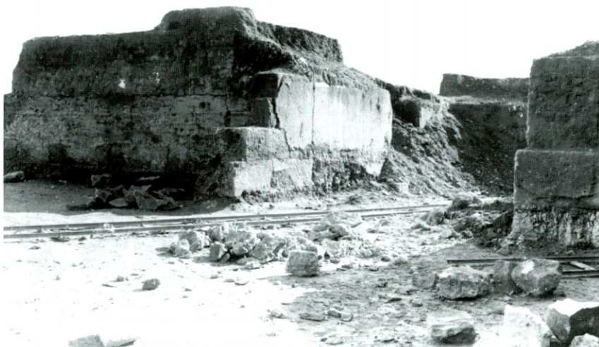
Làm. 23. - Carrer de Cervantes i Lleida, amb restes del Fòrum i obra d'enderroc. Arxiu J.V.S.
