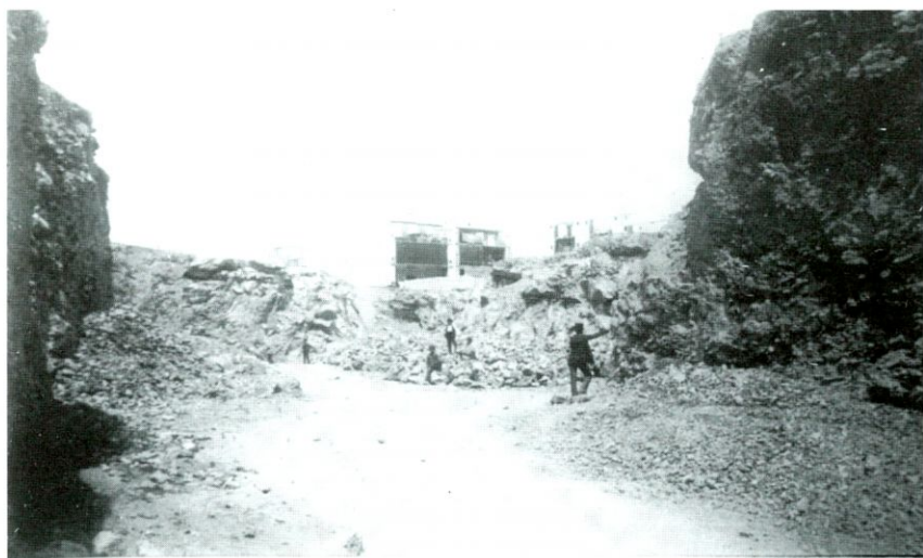
Desmuntatge per la apertura de la plaça del Progreso.
