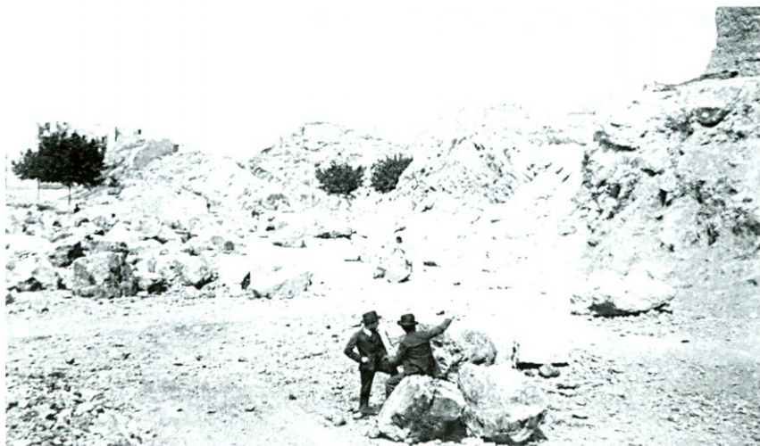
Desmuntatge de la secció de la calçada de Ronda en el estanc de la Rambla de S. Joan
