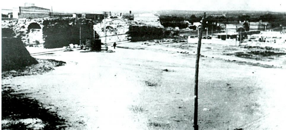
Làm. 18.- La plaça del Progrés (Corsini), ja rebaixada. A la dreta el lloc que ocuparia el Mercat, que fou inaugurat el 1915, i que en la fotografia s'està construint. Dóna idea de la cota primitiva del terreny l'altura de les "trinxeres" dels carrers Soler i Lleida a l'esquerra de la fotografia. Observi's el cripto-pòrtic existent a l'actual edifici de Correus, que podria estar relacionat amb el primer Convent de Caputxins. Arxiu JVS.
