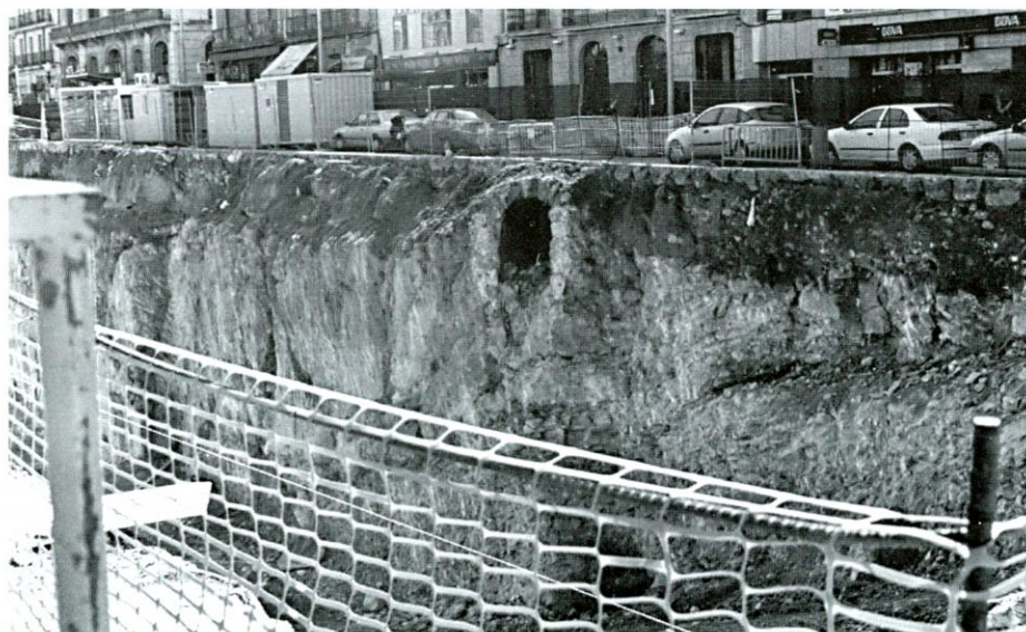
Làm. 29. - La mateixa embocadura una vegada "excavada"
