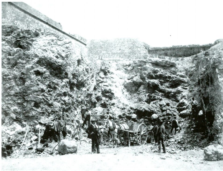
Desmunte para la apertura de la calle del Lulito.
