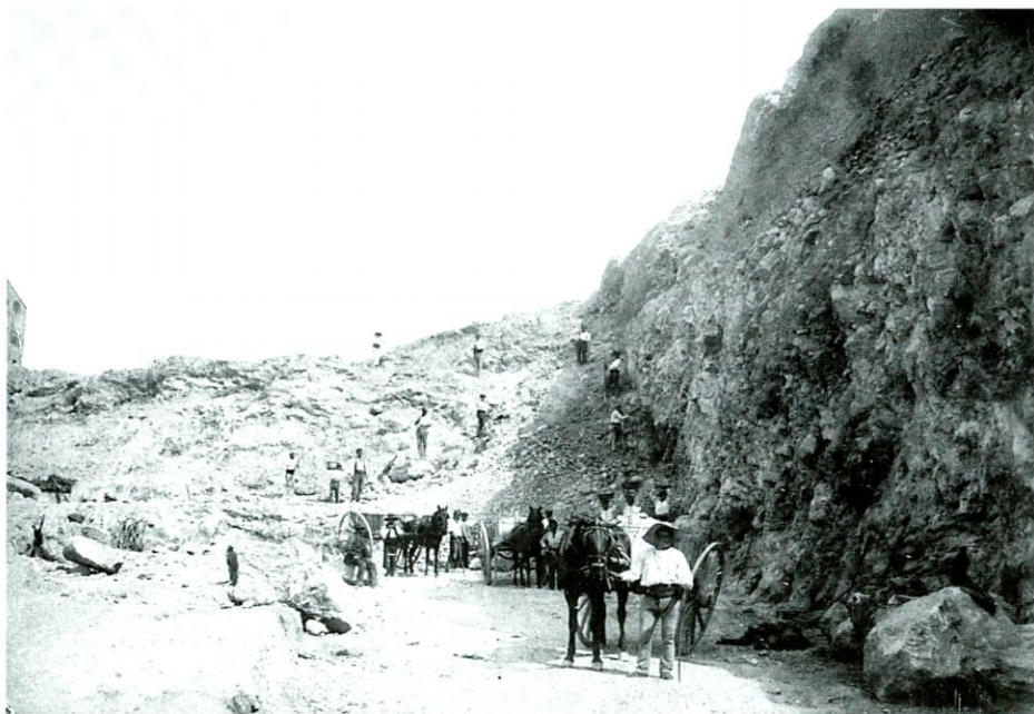
Desmunte de la catle de Augusto desde la del Asolto a la Carretera de Alcolea
