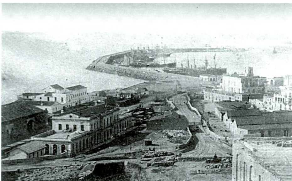
Làms. 4 i 5.- Comparatives de vistes del port, des del que després seria carrer Pons d'Icart. A la de dalt podem veure que entre l'Estació del ferrocarril (el servei amb Barcelona s'inaugurà el 1864) i casa Grasset encara hi ha un bon crestell de roca. La de baix podria ser de finals dels anys setanta del mateix segle. Arxiu Valentines RSAT.
