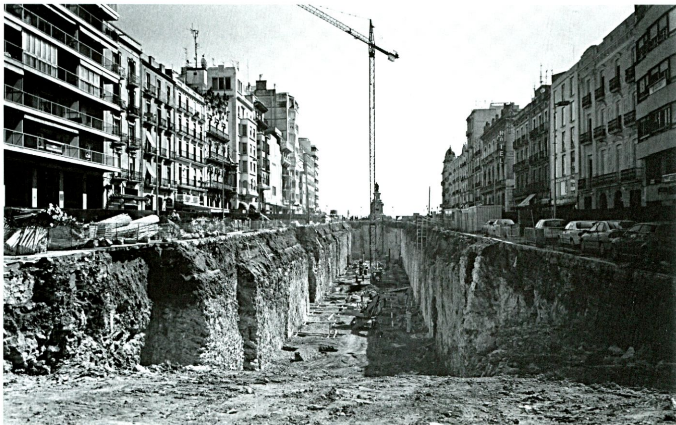
Làm. 27. - Tram nord de la Rambla Nova amb l'excavació per a construir un aparcament. A la dreta es veuen les restes de la claveguera dels jesuïtes que la travessava
