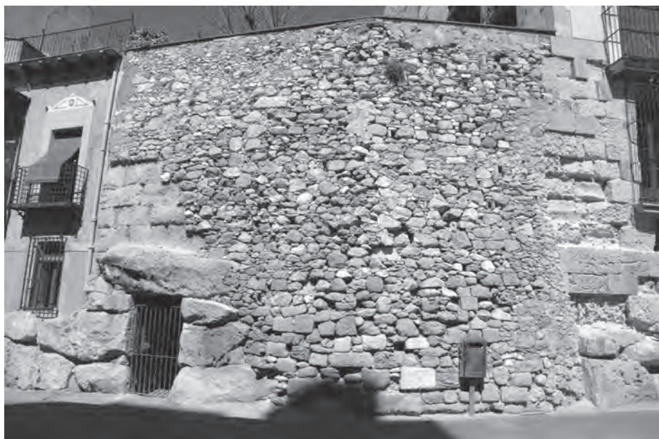
Figura 12. Estado actual del portón ciclópeo de la muralla (Foto C. Salom).
