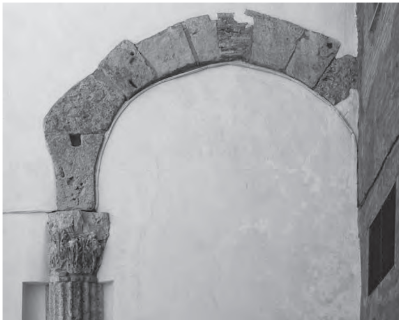
Figura 27. Vista del arco sobre la columna de plaza Rovellat (Foto C. Salom).
