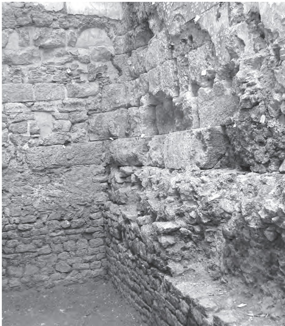
Figura 16. Detalle de la cimentación del lateral oriental del recinto de culto mediante muro de mortero forrado de sillarejo e hileras superiores de sillares (archivo Codex).
