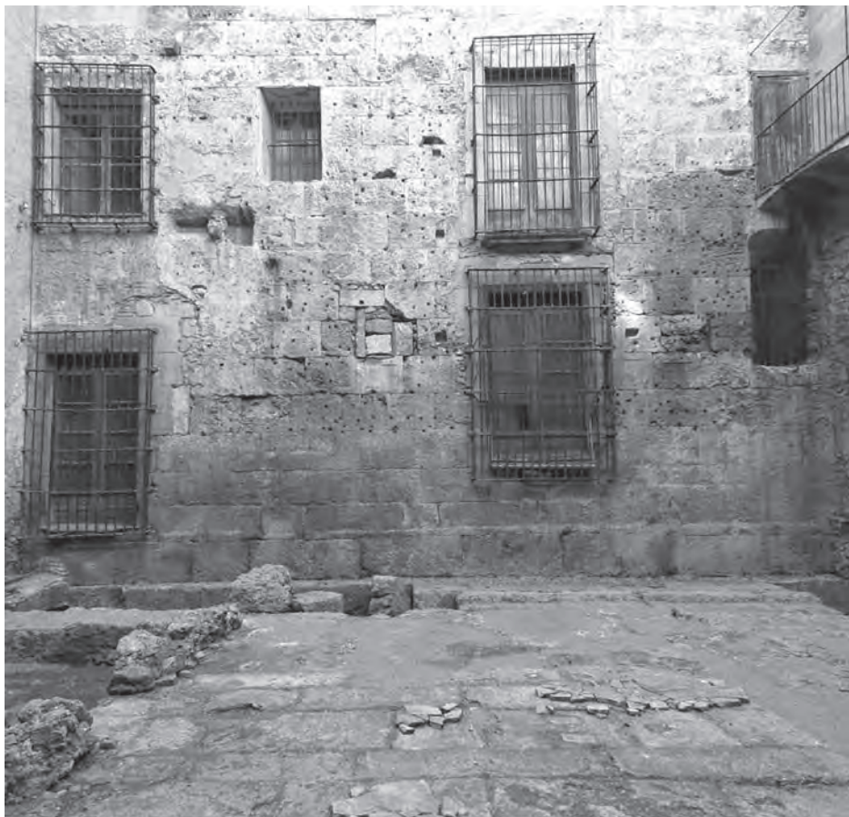
Figura 15. Detalle del paramento interior del muro occidental de la gran sala axial. Se deduce la presencia de un podio perimetral por la cota de aparición de los encajes del placado marmóreo (recorte de fotografía de Quim Vendrell).
