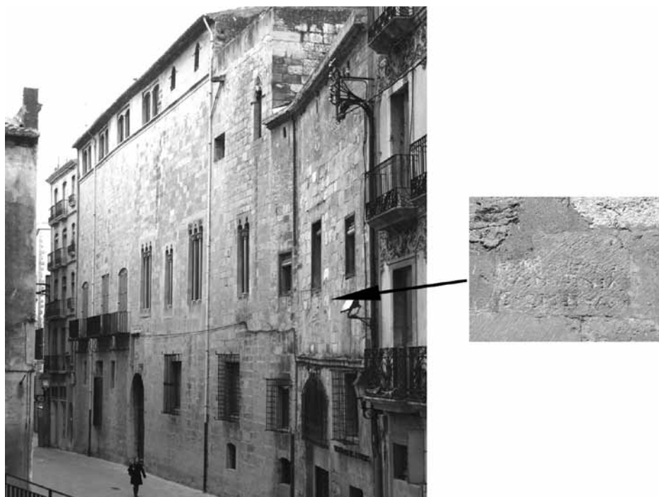
Figura 2: Vista del Palau Bisbe i edificis colindants, des de la catedral, amb indicació d'un fragment d'inscripció romana.
