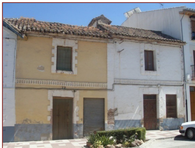
Figura 10: Modelo de dos plantas con puerta y ventana únicas. Alhama de Granada.
