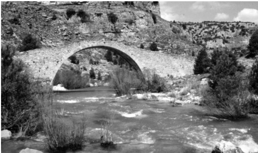
El Pont, sobre el riu Monlleó, per on passa el camí Real cap a l'Aragó.
