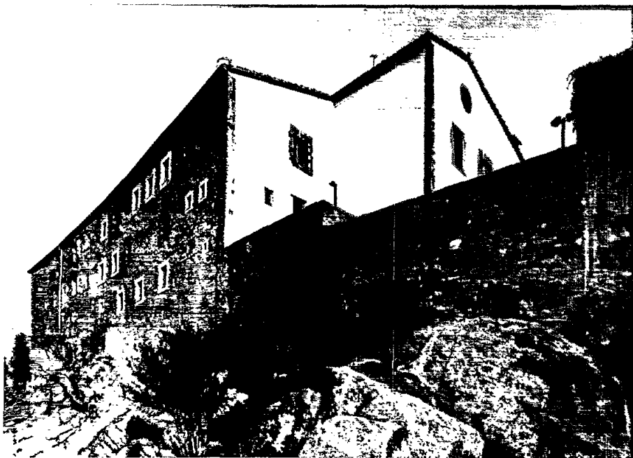
Vista de l'ala nord de l'ermita formada pel primitiu cos medieval, a l'est, i l'ampliació del segle XVI, en primer terme (Foto: Jordi Isern, SPA, 22 de maig de 1990).
