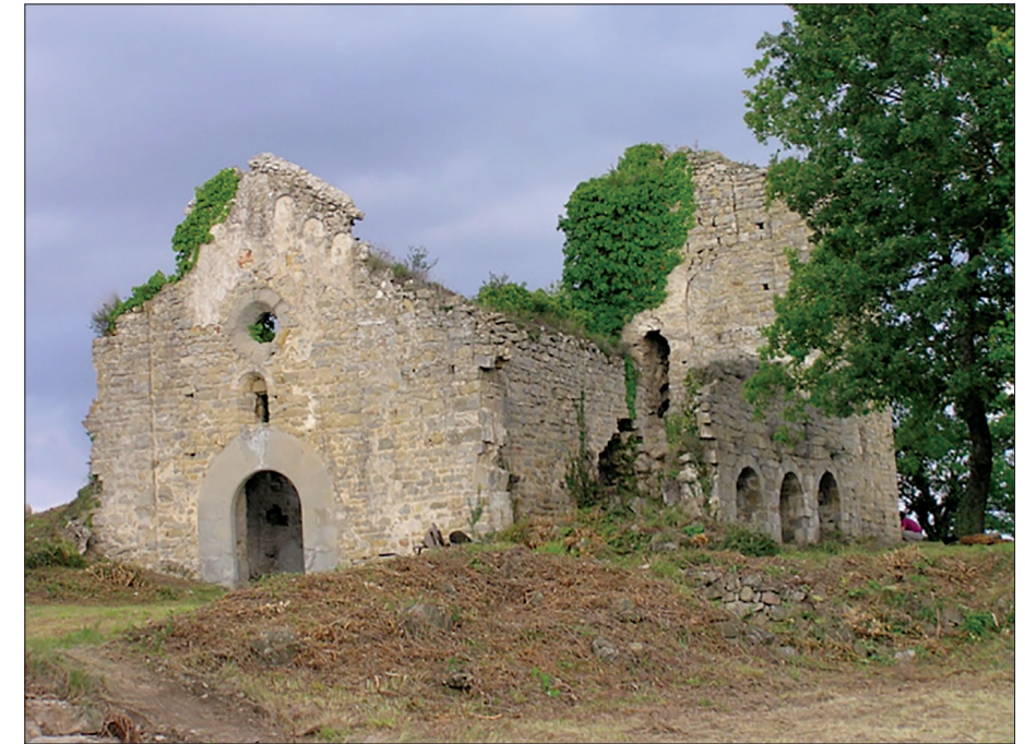
Imatge de l'església de Santa Maria de Besora. Estat actual. Font: ATICS SL.
