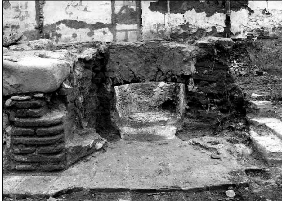
Figura 13. Detall d'un dels forns de calç al fons del pati d'una caseta del segle XIX (foto: C. Jiménez).
