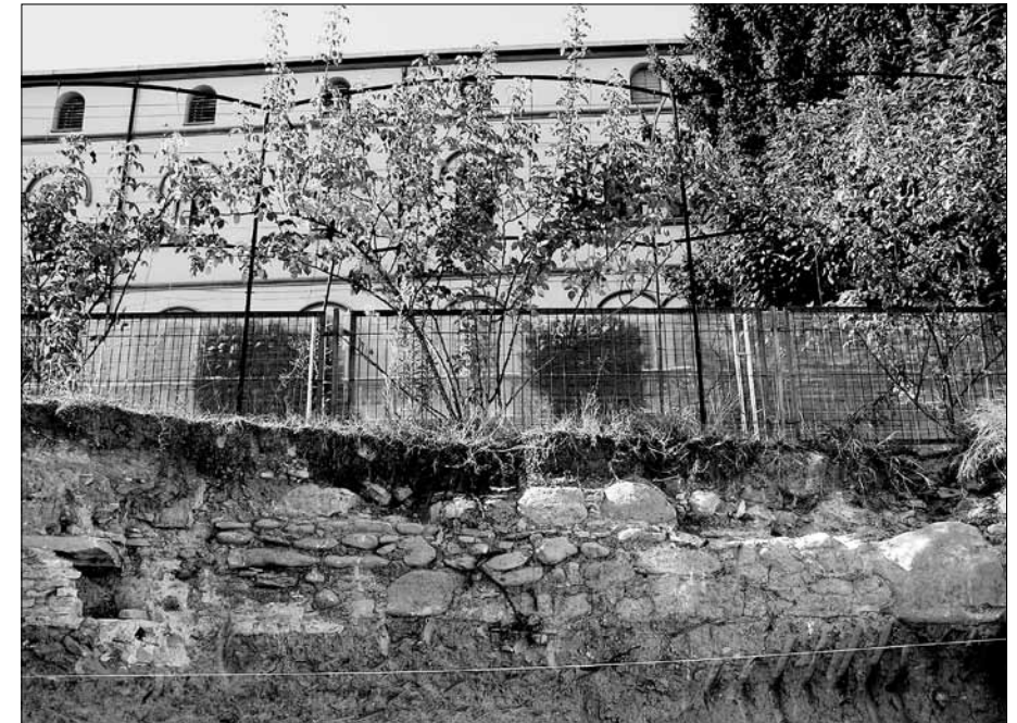
Figura 11. Basament de mur de pedra i morter que, pel traçat, podria correspondre a l'antiga «muralla del morbo».
