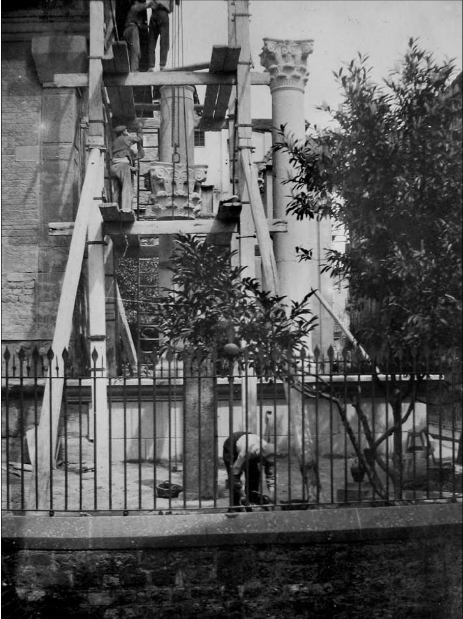
Instal·lació de la columna dels germans Masferrer, acabada de col·locar el 14 d'abril de 1928. (ABEV, Fons Puigneró)
