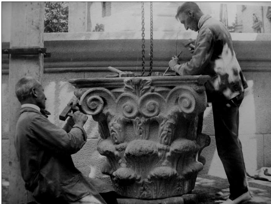
Darrers retocs al capitell de la columna dedicada al canonge Collell poc abans de ser instal·lat (6 de setembre de 1927. (ABEV, Fons Puigneró)
