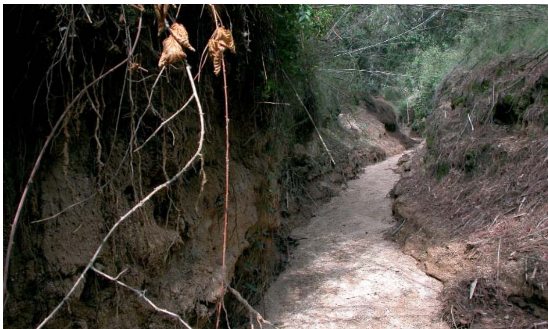
Figura 1. Alguns torrents de la conca de la riera de Valldeix, com el de Can Bruguera, encara mostren un aspecte força natural en contraposició a altres zones que han estat fortament modificades (Foto: J. Corbera).
