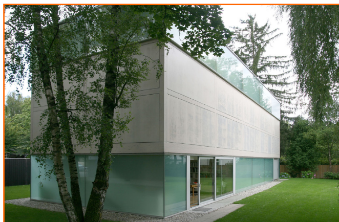
Fig. 11. El vidrio de la Fundación Goetz refleja fenomenológicamente el estado de su entorno ajardinado pero impide la penetración a su través.
