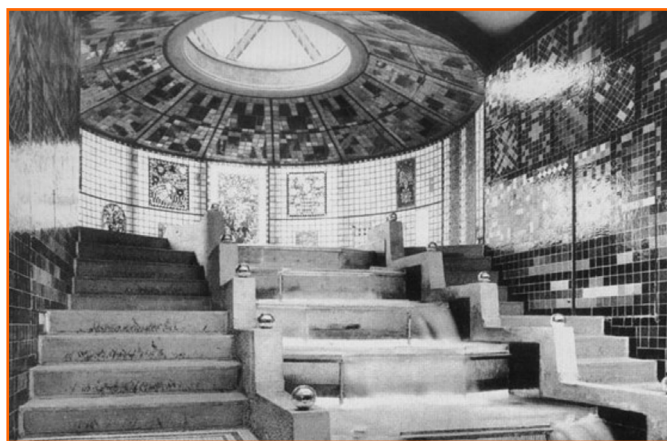
Fig. 2.2. Interior del Glass Pavilion, donde la luz a través de los reflejos multicolores de la policromía del vidrio, tallado en y desde todas las direcciones, induce al visitante a una experiencia de movimiento y cambio, adentrándose en un espacio desconocido en el que se pierden las referencias estables. Un nuevo orden en el que uno se encuentra suspendido a través de un ejemplo de expresión de un mundo nuevo, en el que el uso del vidrio va más encaminado a sus capacidades de producción de efectos en el sujeto 16 que a la interpenetración espacial en un sentido, que quedaría así fuera de la tradicionalmente entendida ortodoxia moderna.
