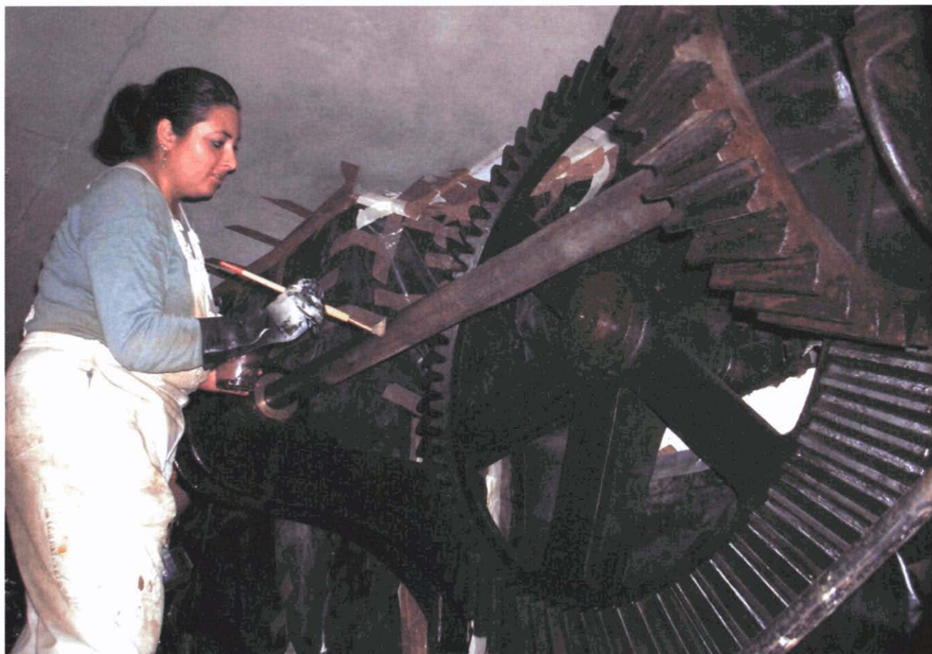
Fotografia 4. Treballs de restauració dels mecanismes de transmissió de la planta baixa: engranatges i embarrat, any 2008. (Arqueociència Serveis Culturals, SL).
