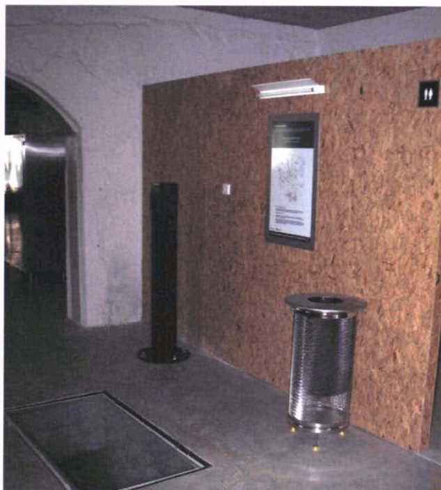
Fotografia 6. Planta baixa: espai de l'antic molí fariner on es pot observar el carcà s'oterrani, un cop finalitzades les obres de rehabilitació, any 2009. (MHS).
