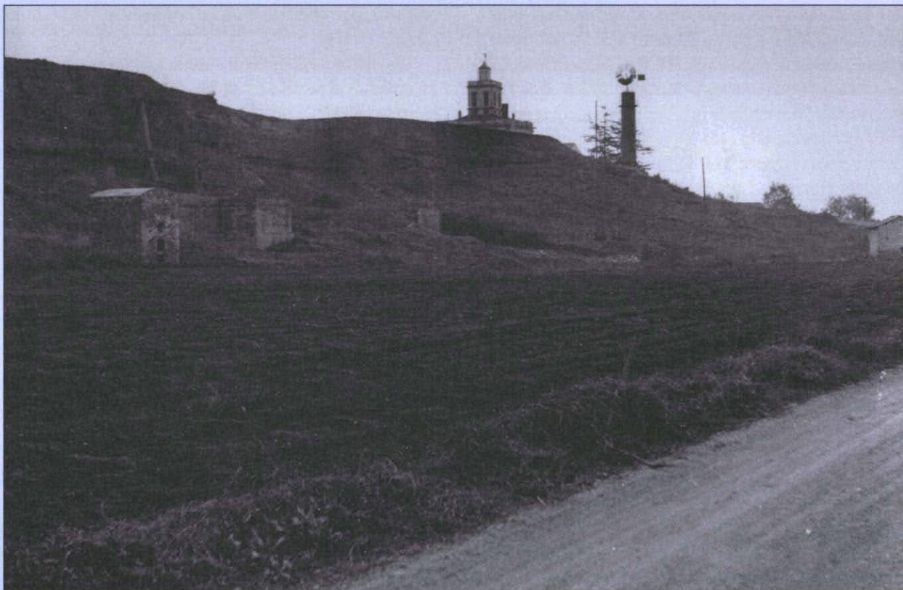
Fotografia 1. Les dues entrades al refugi i polvori de l'aeròdrom de Sabadell, tal com es conservaven l'any 1954, poc abans de començar-se a construir el Club de Tir Sabadell. La construcció que es veu a l'esquerra és un forn metal·lúrgic que va servir a la mestrança d'aviació allí instal·lada i, al fons, la torre Gorina. Fotografia: Francesc Esteve i Soley.
