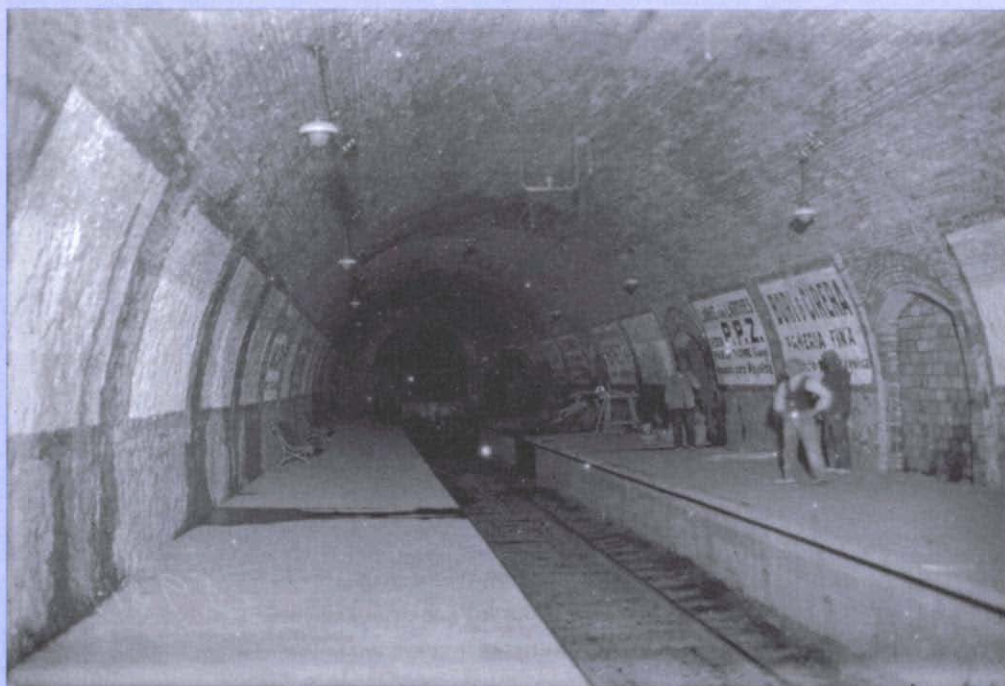
Fotografia 14. Refugi antiaeri del carrer de Buxeda: galeria oest, amb l'accés original sud tapiat i la banqueta. Fotografia: Toni Peñarroya / MHS, octubre de 2008.
