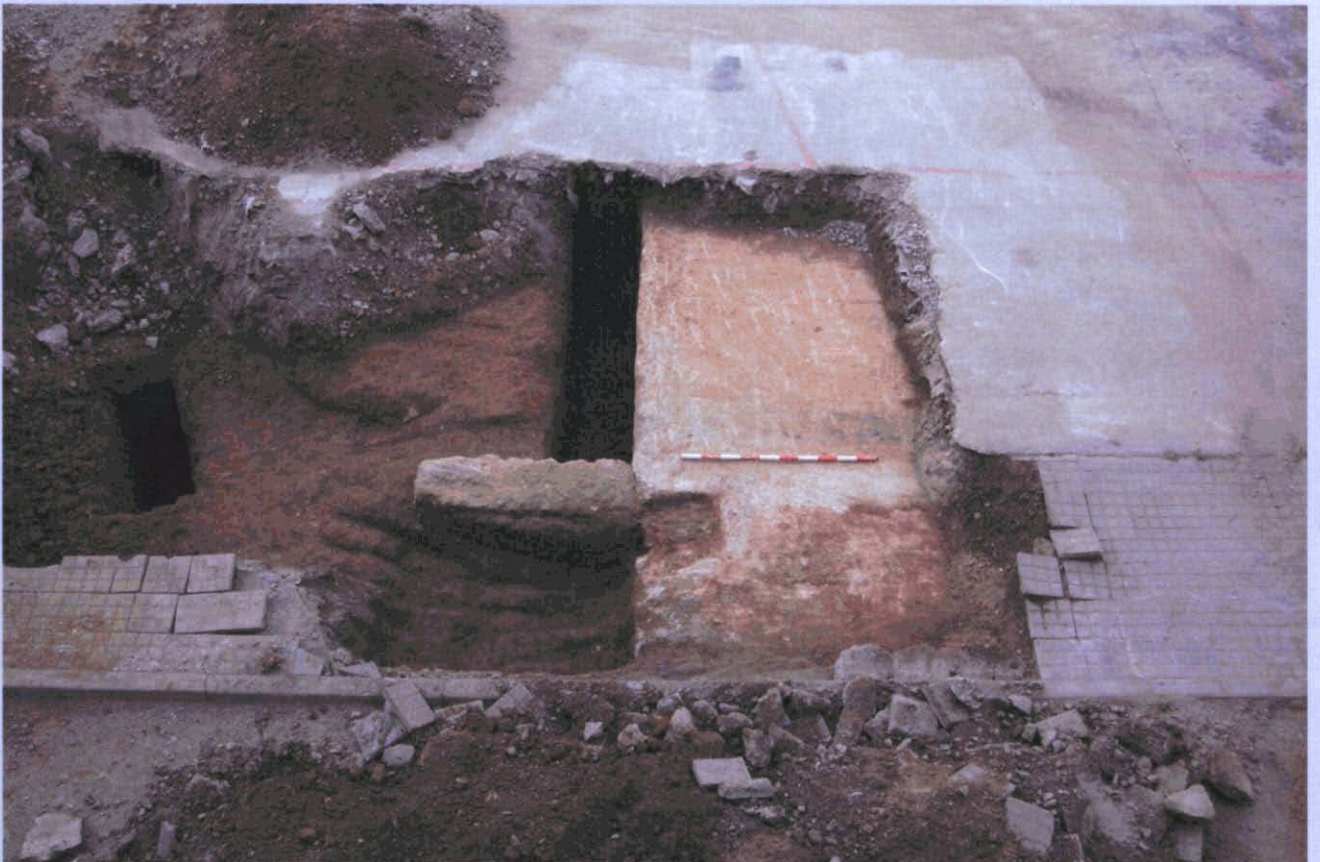
↓ Fotografia 12. Localització arqueològica de la llosa explosiva del refugi de l'IES Pau Vila, amb un dels forats de ventilació laterals. Fotografia: Josep Frigola / Janus, SL, març de 2008.
