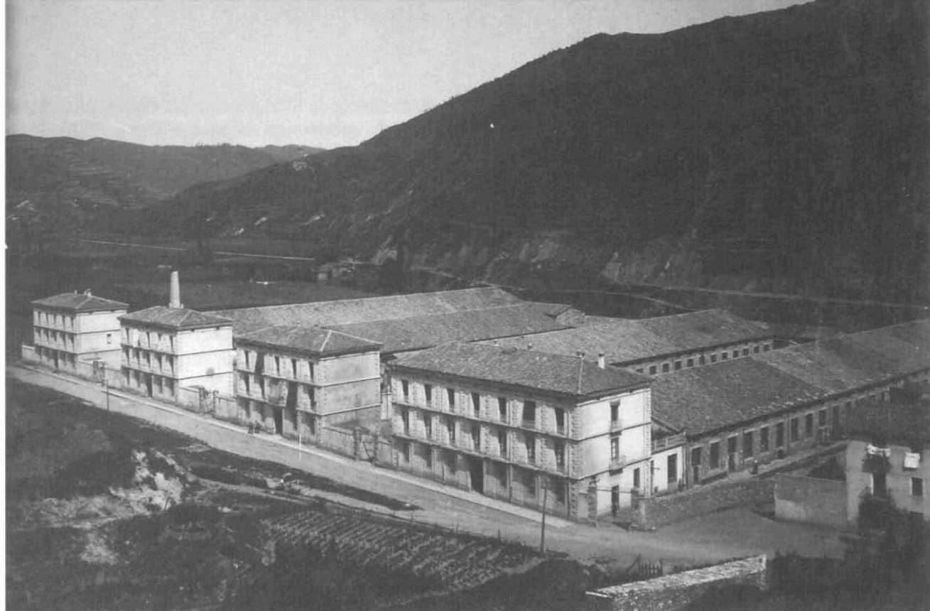
Fotografia 1. Façana principal de la fàbrica de Josep Badia a Ripoll. Autor: Josep Guic, 1895, extreta de: Aprovechamiento de aguas del río Ter en Ripoll: propiedad de José Badía Capdevila , Sabadell: imp. Juan Comas, 1904, (AHS. Fons Badia).
