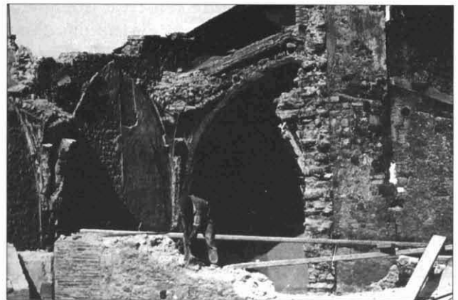
FOTOGRAFIA 3. Detall de la volta gòtica de l'església durant els treballs de neteja; s'observa el farciment de peces de ceràmica i morter dels carcanyols (data aproximada, any 1910) (Arxiu Casanyes, MHS, núm. 2759).
